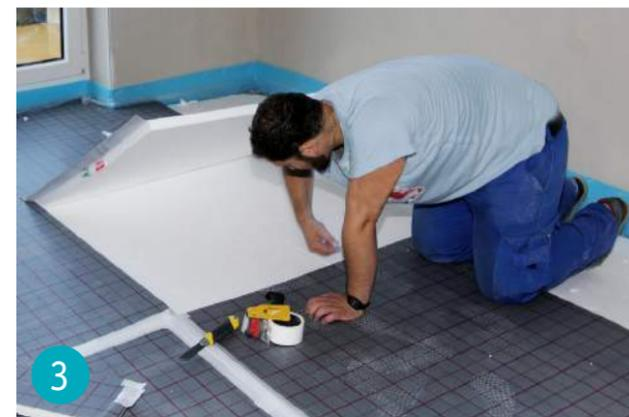
3 Beginnend in einer Ecke des Raumes die Tackerplatten so verlegen, dass sie bündig mit dem Randdämmstreifen abschließen. Die Systemplatten anschließend mit PE-Klebeband verkleben, um die Stabilität und Dichtigkeit zu erhöhen.
