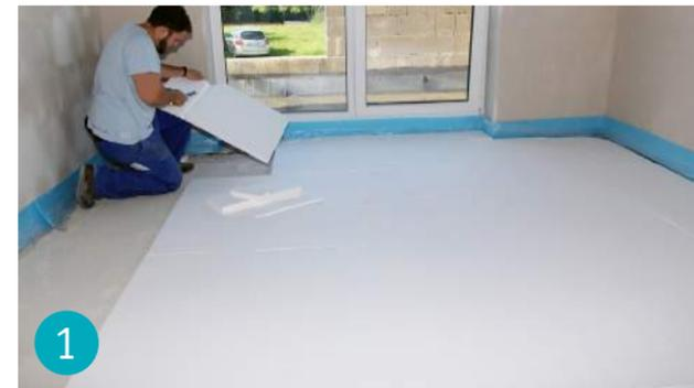
1 Untergrund mit dem Besen reinigen und von Unebenheiten befreien, sodass eine ebene und saubere Fläche entsteht. Zusatzdämmung zuschneiden und in den vorgesehenen Bereichen verlegen.
