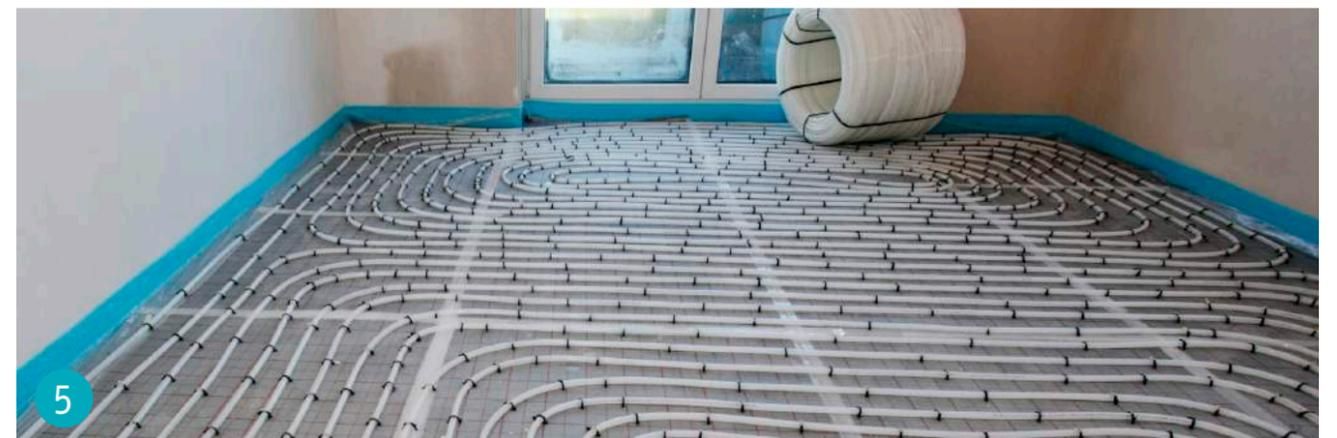
5 Nach Verlegung der Fußbodenheizung Heizrohre befüllen und entlüften, um die Anlage einer Druck- und Dichtigkeitsprüfung zu unterziehen. Anschließend kann der Estrich eingebracht werden.
