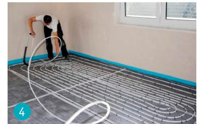
4 Beginnend am Heizkreisverteiler erfolgt die Heizrohrverlegung gemäß der vorgegebenen Verlegeabstände. Das Heizrohr wird mithilfe eines Tackergerätes mit Ankerclips auf der Systemplatte befestigt.
