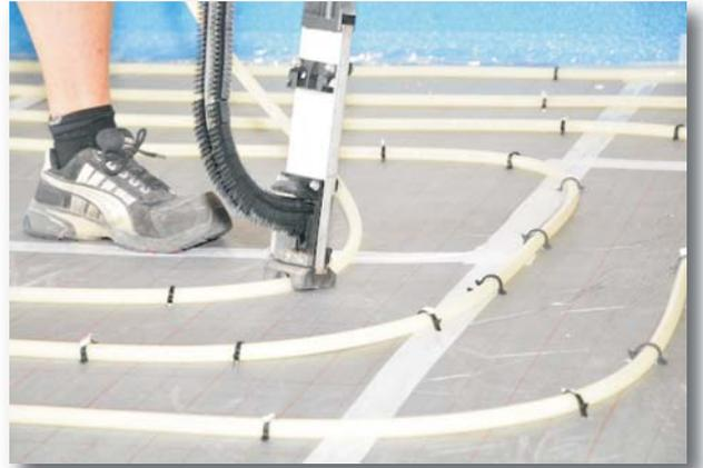
Sobald die Mitte des Heizkreises erreicht ist, machen Sie eine Wendung und verlegen das Heizrohr zwischen den bereits vorhandenen Heizrohren zurück. Dadurch entsteht der letztendlich berechnete Verlegeabstand.
