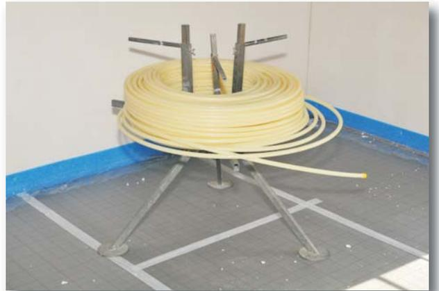
Beginnen Sie mit der Verlegung des Heizkreises jeweils am Heizkreisverteiler. Schließen Sie das Heizrohr am Vor- oder Rücklauf an und befestigen Sie das Rohr mit den Ankerclips entsprechend der gewünschten Verlegeart ca. alle 50 cm. Vor und hinter Bögen sollte jeweils ein Ankerclip gesetzt werden.
