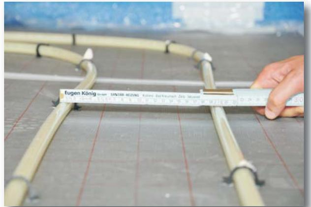
Sobald der Heizkreis fertig verlegt ist, schließen Sie auch dieses Ende des Heizrohrs mit den mitgelieferten Klemmverschraubungen an den Heizkreisverteiler an. Bitte beachten Sie, dass ein Heizkreis nicht länger als 100–120 Meter sein sollte (inklusive Zuleitungen zum Heizkreisverteiler).
