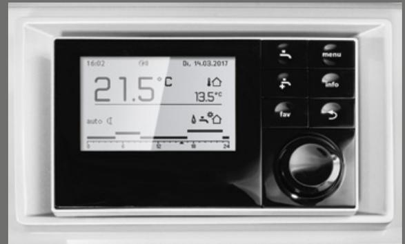
Die Logatherm WLW196i AR ist dank des bekannten Regelsystems Logamatic EMS plus und der Bedieneinheit Logamatic HMC300 serienmäßig für eine Internetanbindung ausgestattet.
