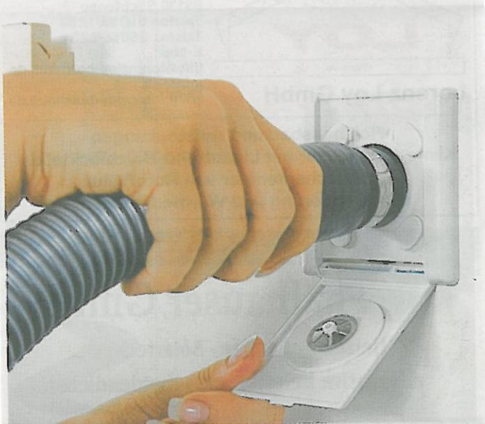
Durch das Rohrsystem wird die belastete Luft zum Zentralgerät befördert, gereinigt und von dort ins Freie oder in die Umgebungsluft des Gerätes abgegeben.
