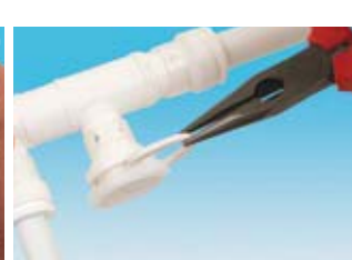
Zwecks Inbetriebnahme: Clip mittels Spitzzange herausziehen.
