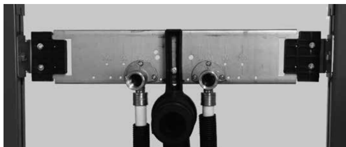
Schallentkopplung der Traverse vom Modulrahmen
