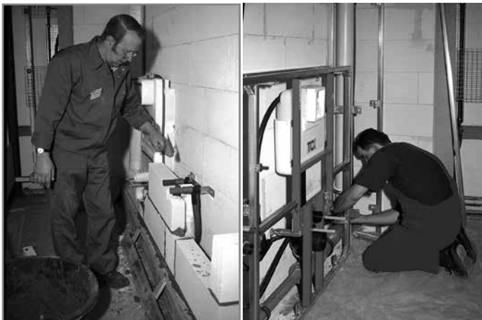
Nassbau (links) gegen Trockenbau
